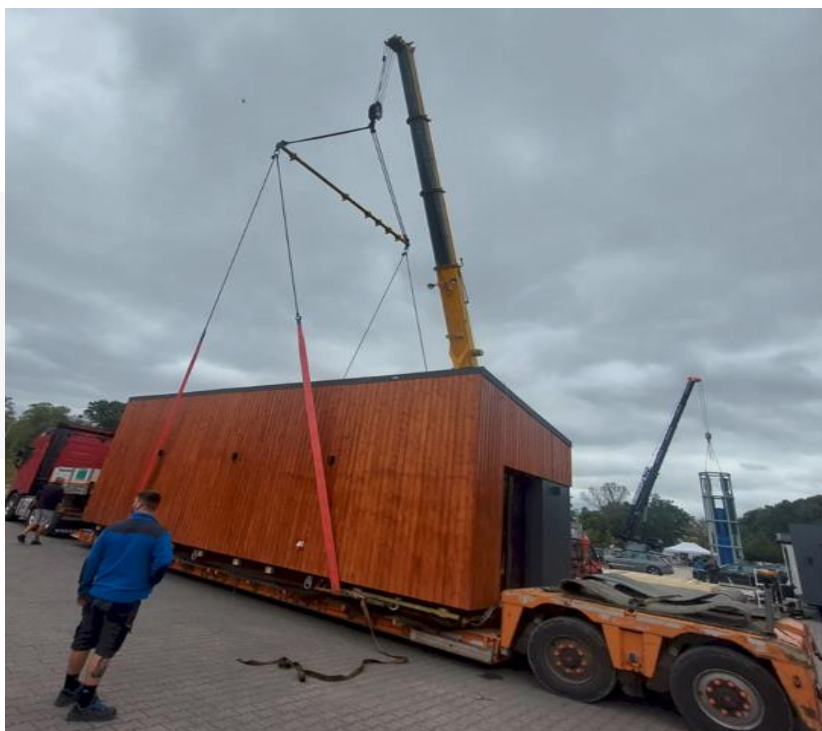
Rys. Przykład rozładunku przy użyciu trawersy
